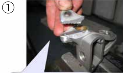
① 上下の差し込み部が折れました
